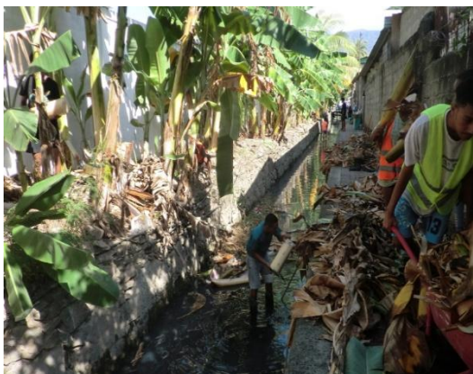
Figura 7: Limpeza Esgotu iha área Suku Gisenfor
