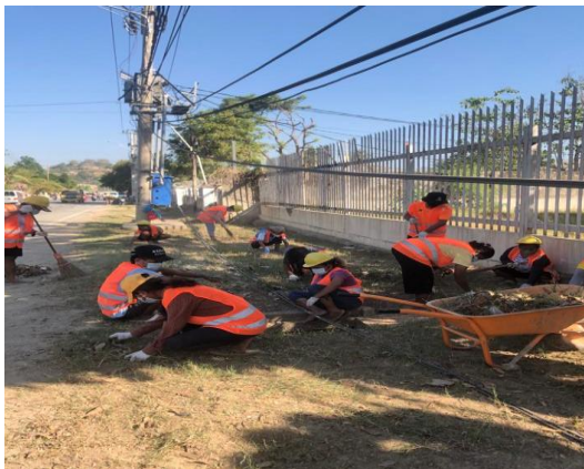
Figura 1: Limpeza Estrada iha área Suku Becora
