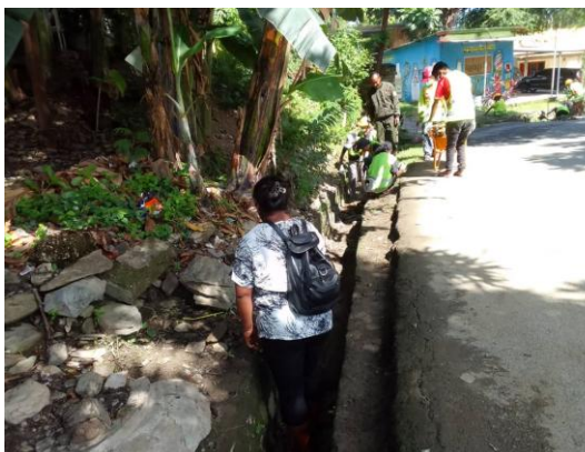
Figura 11: Limpeza Esgotu iha área Suku Vila verde
