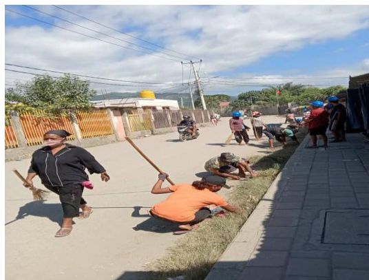
Figura 12: Limpeza Esgotu iha área Suku Fatuhada
