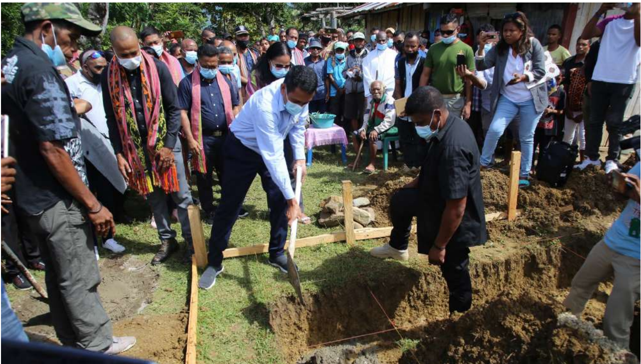
Sua Excelência, o Senhor Ministro, Miguel Pereira De Carvalho, procede à cerimónia de "lançamento da primeira pedra" da construção de uma habitação UKL no Posto Administrativo Uatucarbau no Município de Viqueque.
