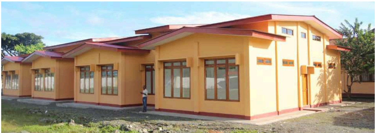
Edifício de reuniões e encontros da Autoridade Municipal de Ermera, construído no âmbito do PDIM.
