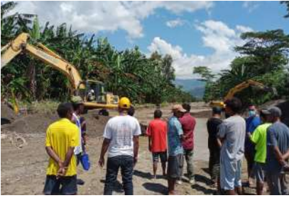
Acompanhamento dos trabalhos de limpeza do leito da ribeira na aldeia de Ailok, Suco Hera, no PA de Cristo Rei em Díli.
